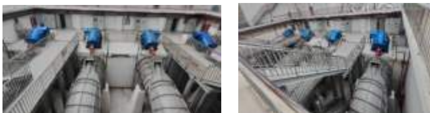
上海航塘港南延伸工程【4×900kW】斜式轴流泵永磁电机
