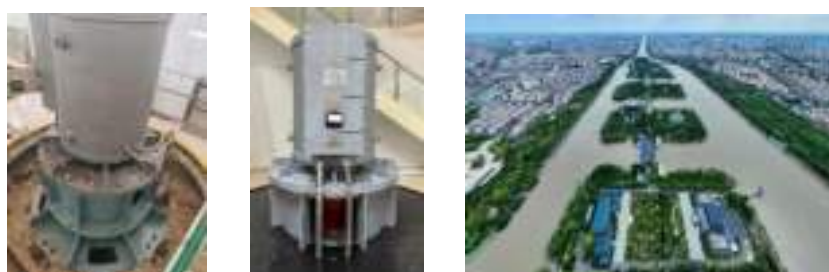
“南水北调”工程江都水利枢纽【1200kW】立式混流泵永磁电机
